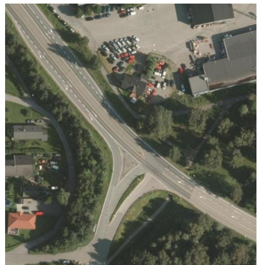
Figur 17 Kryss mellom Fv283 og over Mjøndalsbrua.
