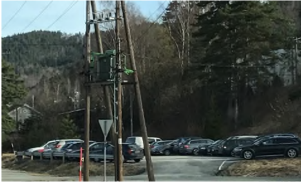
Figur 3.6: Gratis parkering er opparbeidet i Tuverudveien sør for stasjonen.
